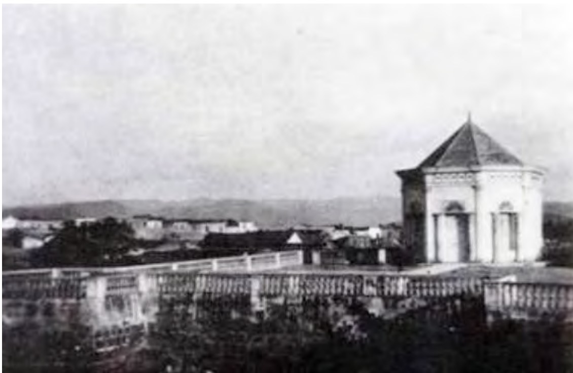
Vista del Castillo de Santa María de la Cabeza. La construcción que se observa en la margen de la foto es la Ermita del Carmen construida por Santos Berrizbeitia, junto con los barandales que rodean la parte superior de la fortaleza. Año de 1915.
